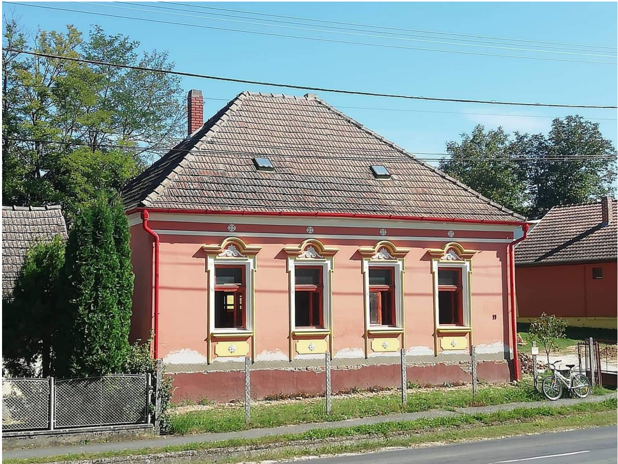
felújítandó Zöldségelőkészítő épülete
