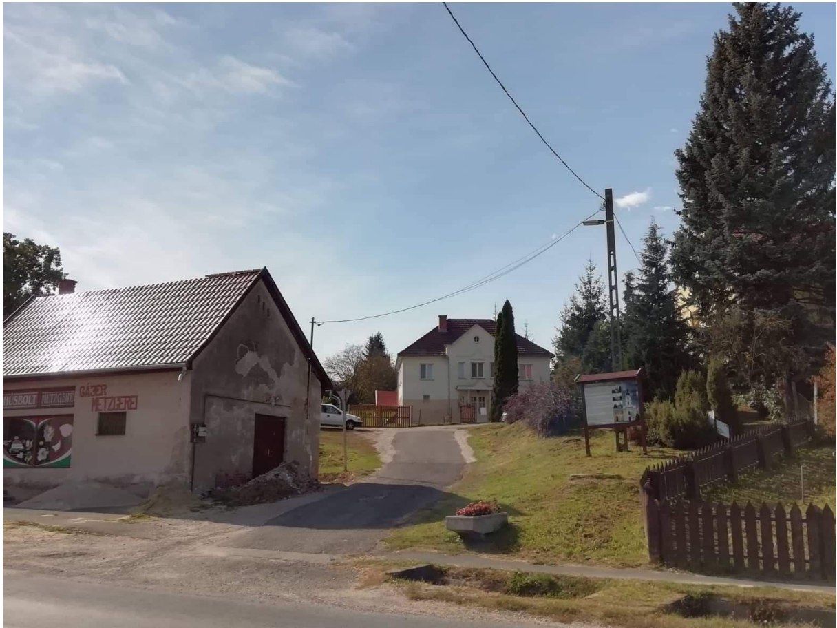
felújítandó üzlet épület
